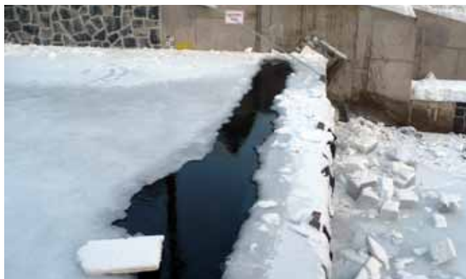
Ledová deska o síle 56 cm trhá hydraulický pohon sklopného jezu v Dolních Štěpanicích. Teplota minus 29 st. Celsia (Foto: HZS Semily)
