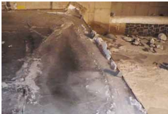
Ledová deska o síle 56 cm trhá hydraulický pohon sklopného jezu v Dolních Štěpanicích. Teplota minus 29 st. Celsia (Foto: HZS Semily)
